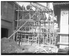
大正時代の工事の様子
