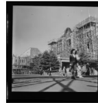
東京駅駅舎修復中。(昭和21年)
