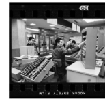
東京駅オープンカウンター出札窓の改善
